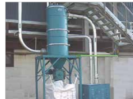
中央气泵 Central air pump
